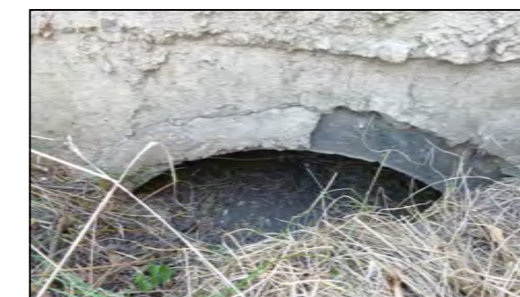
Фото 6. Состояние оголовка на выходе.
