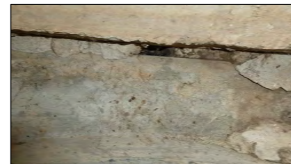
Фото 6. Состояние швов внутри трубы.
