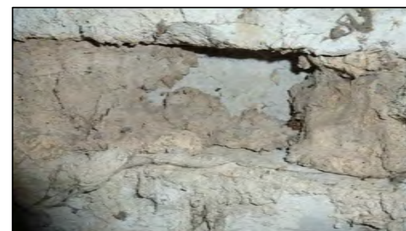
Фото 13. Состояние швов внутри трубы.
