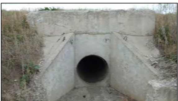
Фото 10. Состояние оголовка и откосных крыльев на выходе.
