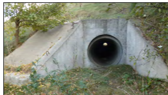
Фото 1. Оголовок на входе.
