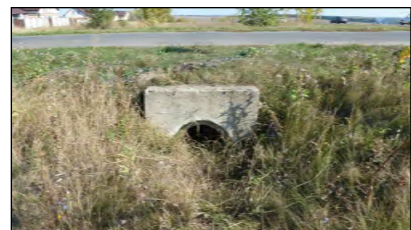
Фото 1. Оголовок на входе.
