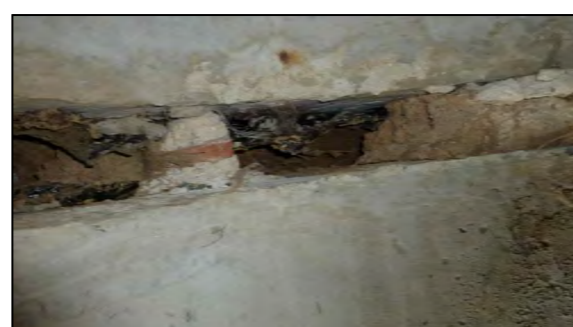
Фото 12. Состояние швов внутри трубы.
