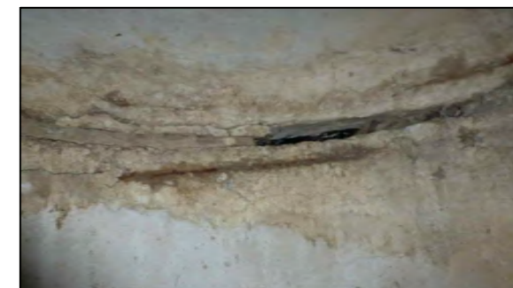
Фото 7. Состояние швов внутри трубы.
