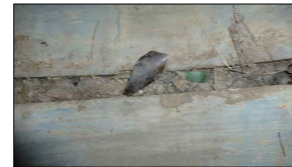
Фото 6. Состояние швов внутри трубы.
