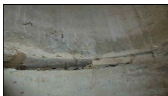
Фото 13. Состояние швов внутри трубы.
