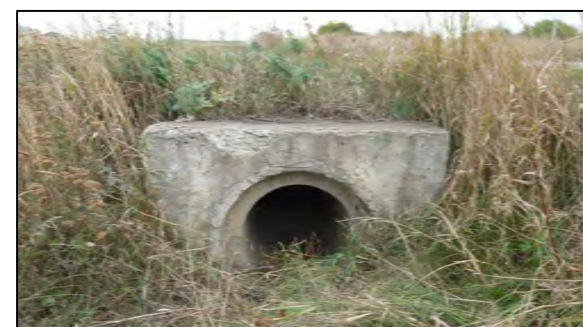
Фото 1. Оголовок на входе.
