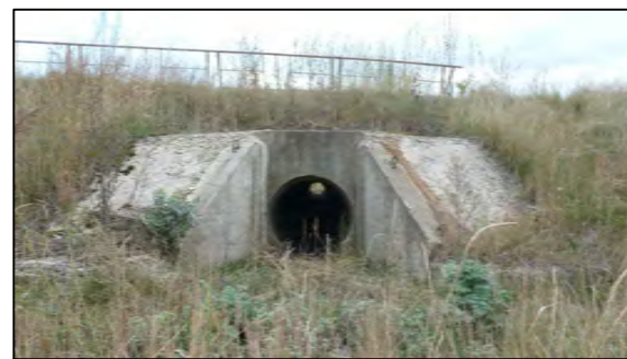
Фото 1. Оголовок на входе.
