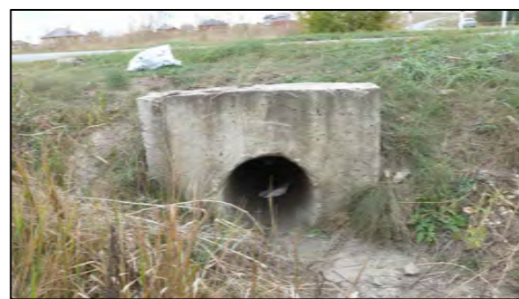
Фото 1. Оголовок на входе.
