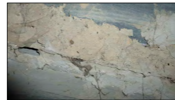
Фото 14. Состояние швов внутри трубы.
