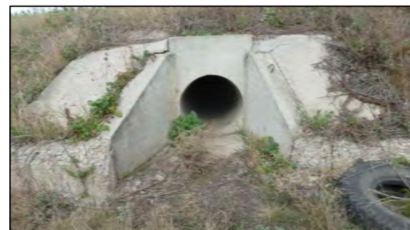
Фото 1. Оголовок на входе.
