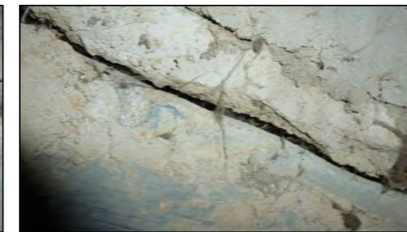
Фото 7. Состояние швов внутри трубы.
