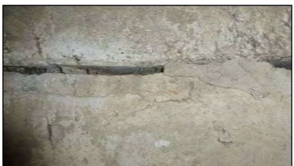
Фото 13. Состояние швов внутри трубы.
