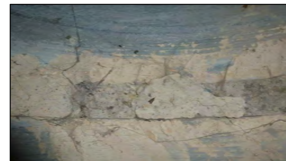
Фото 7. Состояние швов внутри трубы.
