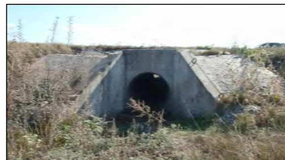
Фото 1. Оголовок на входе.
