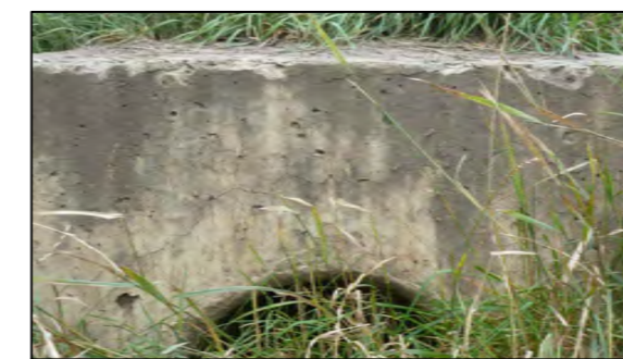
Фото 4. Состояние оголовка на выходе.
