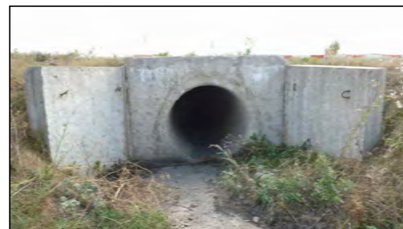
Фото 1. Оголовок на входе.
