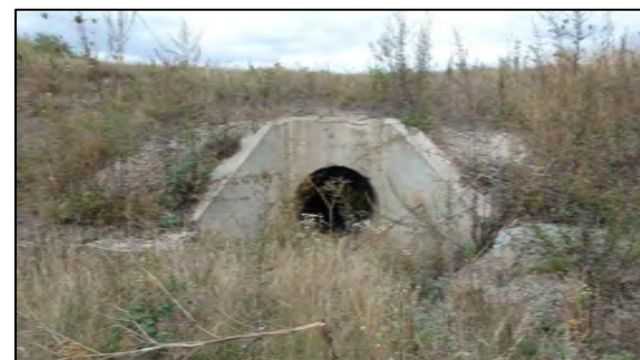
Фото 1. Оголовок на входе.
