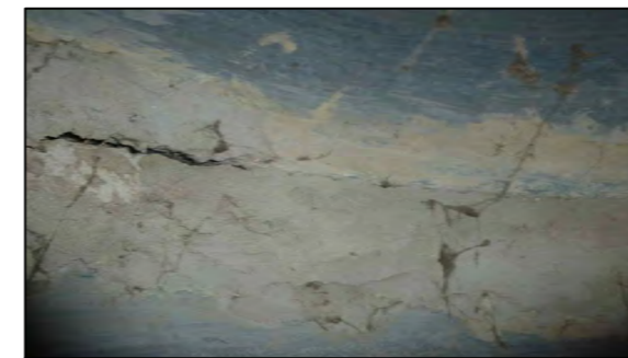
Фото 5. Состояние швов внутри трубы.
