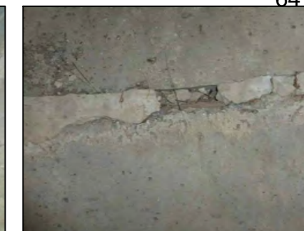
Фото 8. Состояние швов внутри трубы.
