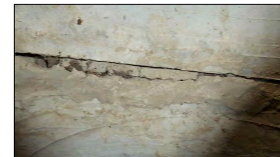
Фото 5. Состояние швов внутри трубы.
