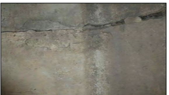
Фото 14. Состояние швов внутри трубы.
