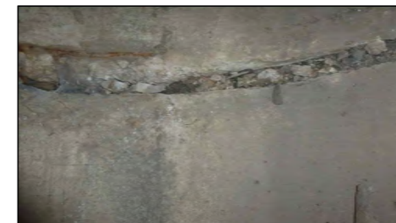
Фото 6. Состояние швов внутри трубы.
