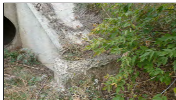
Фото 9. Состояние откосных крыльев и укрепления откоса на выходе.
