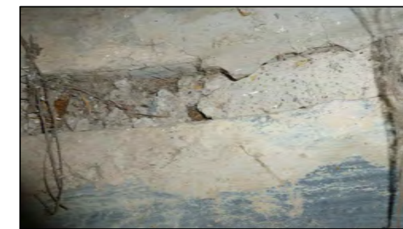
Фото 13. Состояние швов внутри трубы.
